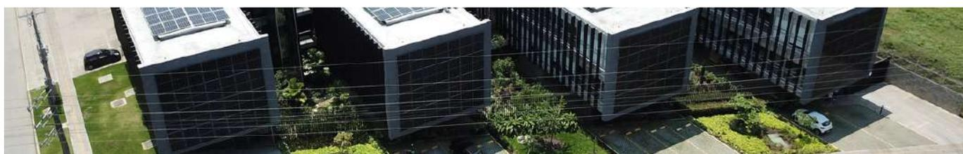
Este sistema de generación fotovoltaica cuenta con una capacidad de 369 kW de potencia instalada y tiene la capacidad de generar el 100 % de la energía necesaria para la operación de las instalaciones, e incluso en algunos momentos podemos exportar a la red excedentes de energía renovable. En el año 2022, este sistema de generación fotovoltaica fue capaz de exportar como excedentes a la red un total de 0,14 TJ de energía.
